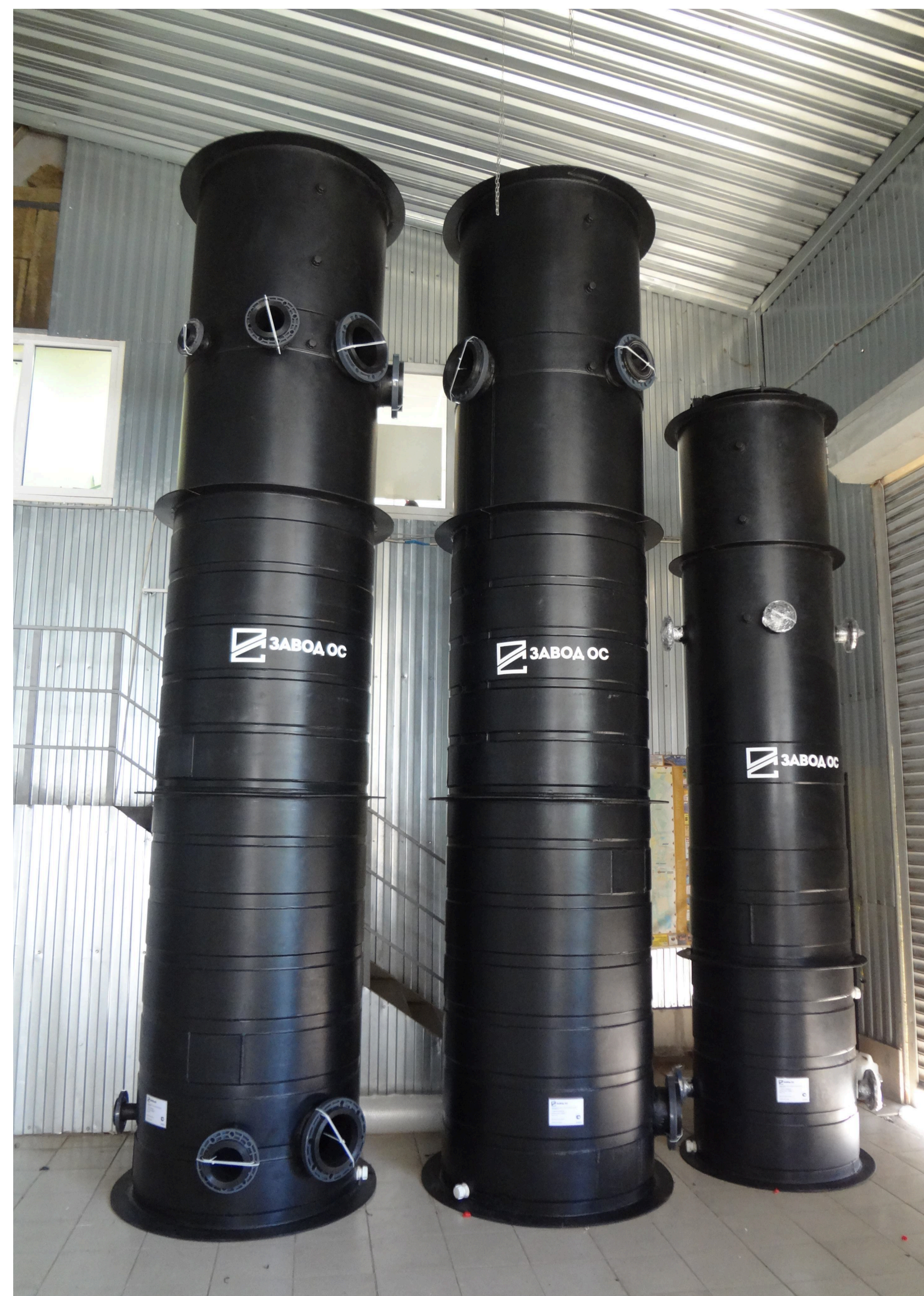
Химстойкие емкости для хранения концентрированной соляной кислоты
