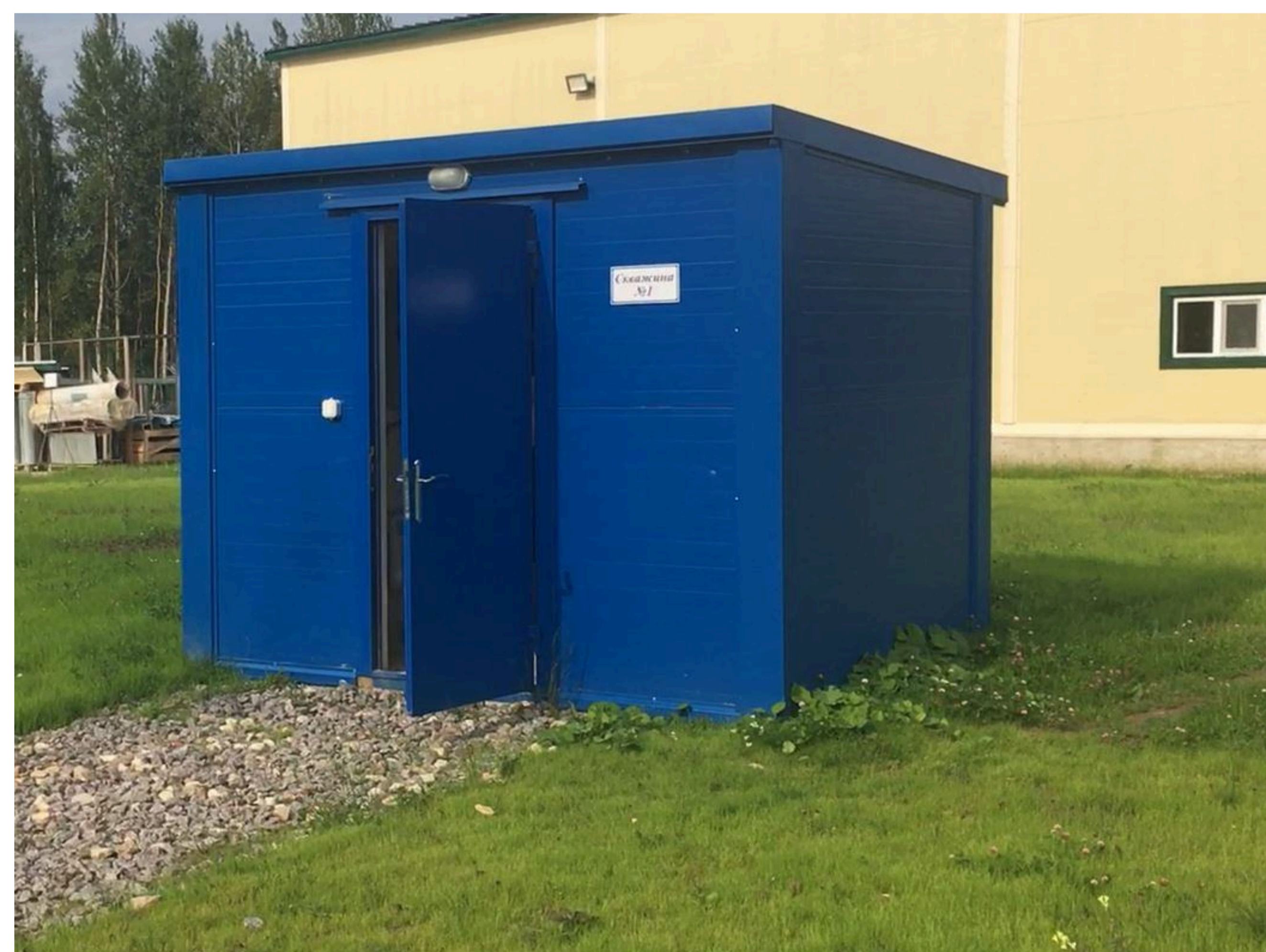
Обустройство скважины ВЗУ
